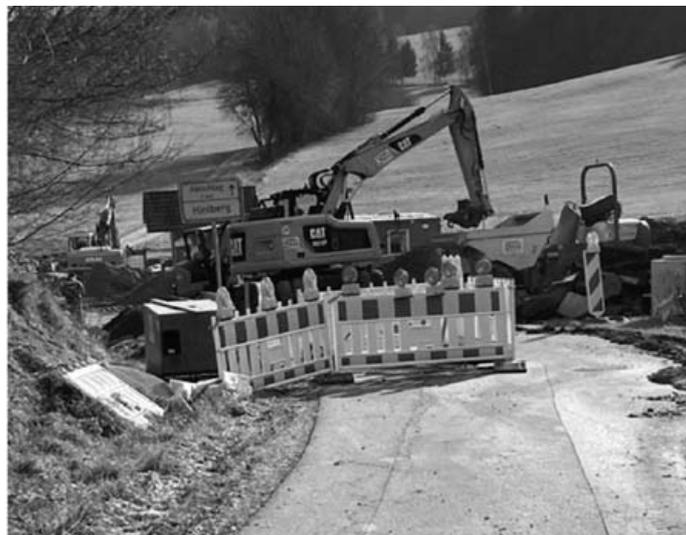
Die Baustelle in Untermittendorf (Kanal-, Wasserleitungs- und Straßenbauarbeiten) wurde von der Fa. Haimler Bau, Viechtach, Anfang November 2023 begonnen. Zunächst wird der neue Ableitungskanal DN700, beginnend oberhalb der Untermittendorfer Kläranlage in Richtung des Dorfes, errichtet. Das komplette Baufeld hierfür wurde bereits hergerichtet. Die ersten Leitungsstränge sind verlegt. Witterungsbedingt wurde die Baustelle Ende November 2023 eingestellt und im Frühjahr 2024 weitergeführt.
