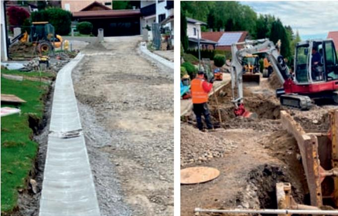
Bei der **Baustelle der Fa. Mader Bau in der Raindorferstraße in Kirchberg** (Wasserleitungssanierung) ist der 1. Bauabschnitt zwischen der Regenerstraße und dem Busbahnhof mit der erfolgten Asphaltierung erledigt. Hier wurde zusätz-
