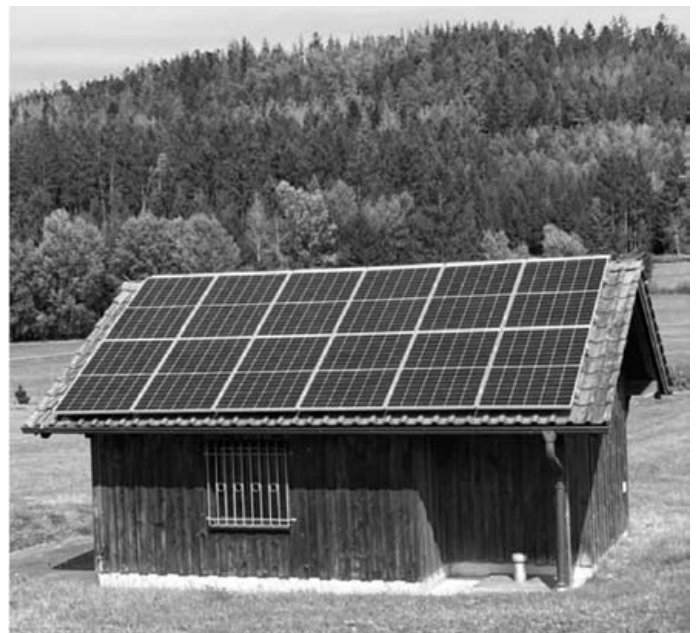
Bild (von Gemeinde): Pumpstation in Zell.
